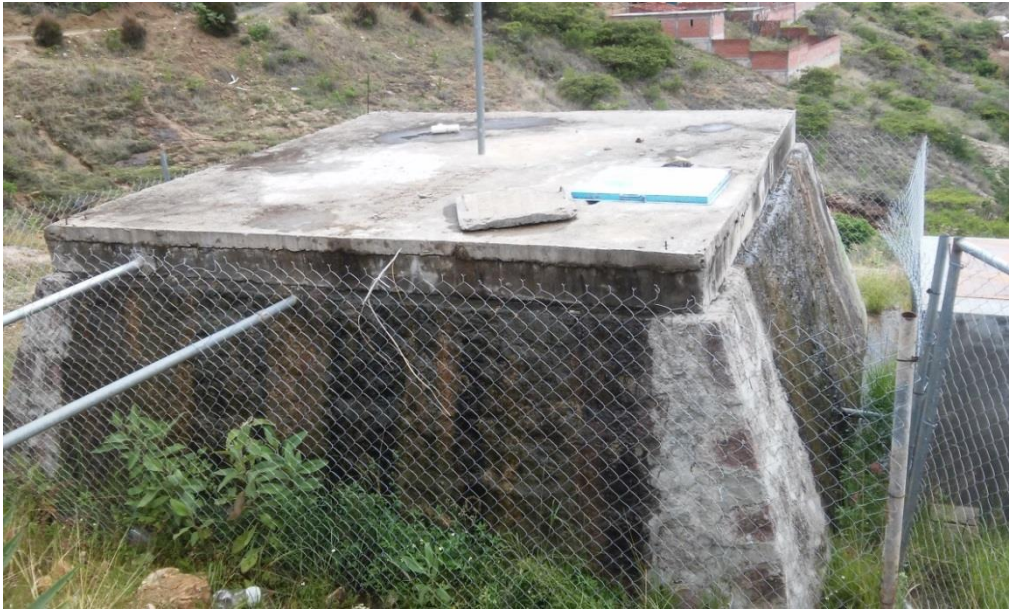
Fotografía 1 Tanque de Agua de la calle Victoria.
