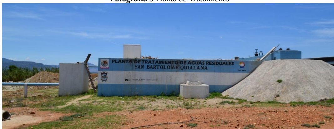
Fotografía 5 Planta de Tratamiento
